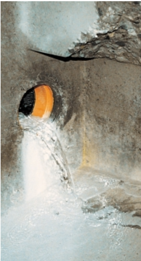
Bereits während der Bauphase entstehen starke Ablagerungen durch die pH-Wert-Erhöhung des Bergwassers. Beide Aufnahmen stammen aus dem Kanton Graubünden.
