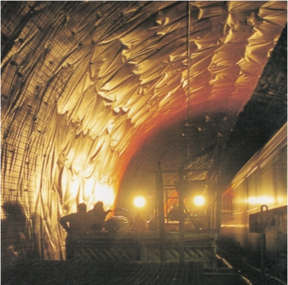
Abb. 10: Aufbringen von KDB auf das Gewölbe, danach folgen die Netze und der Spritzbeton.
