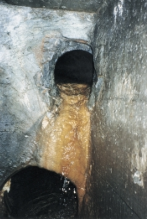
Ablagerung im Belchentunnel durch «normales» kalkhaltiges Jurawasser.
