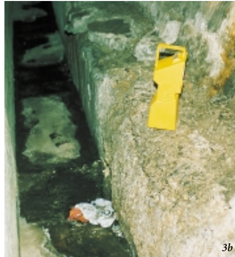
Abb. 3a/b: Zerstörung des Widerlagerbereichs durch Bergwasser, das unter Druck durch die Tunnelschale dringt. Die Zersetzungsprodukte weisen hohe Gehalte an Gips, Ettringit und Thaumazit auf.
