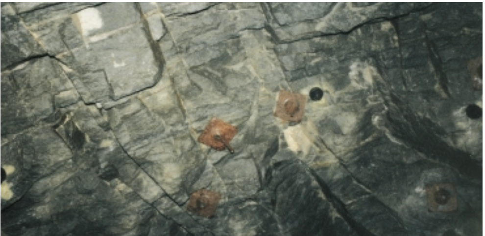
Abb. 5: Stark angerostete Ankerplatten (25 x 25 cm) durch mineralisiertes 1–2 g/l, \text{CO}_2 -haltiges Bergwasser.
