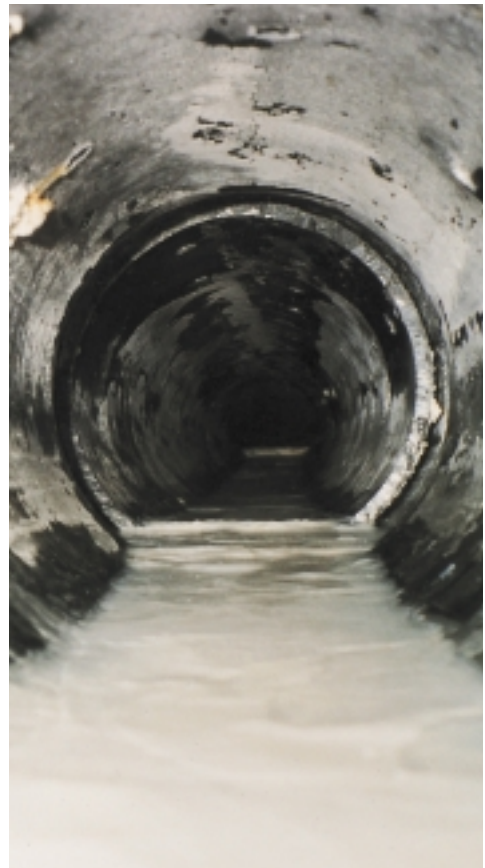
Bereits während der Bauphase entstehen starke Ablagerungen durch die pH-Wert-Erhöhung des Bergwassers. Beide Aufnahmen stammen aus dem Kanton Graubünden.
