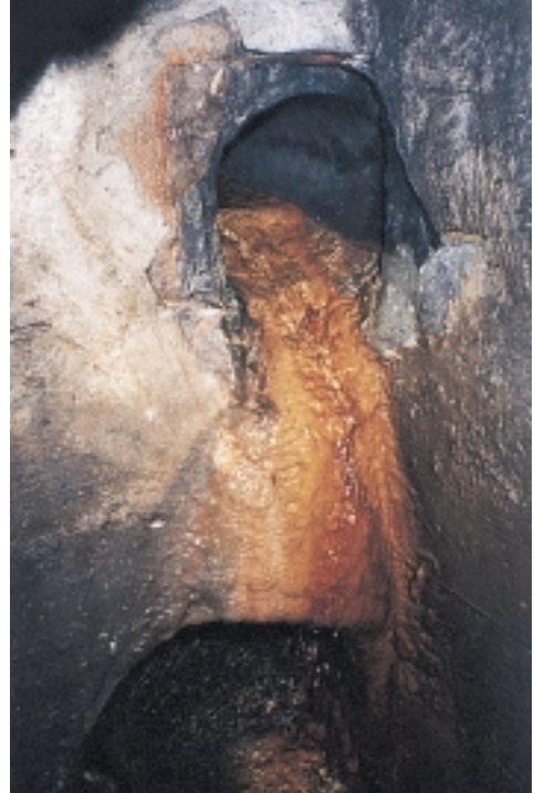
Abb. 5: Entwässerungsleitung \varnothing 20 Oströhre, herkömmliche Kalkablagerungen in mehreren Jahren mit ca. 2% Eisenanteil (rote Farbe).
