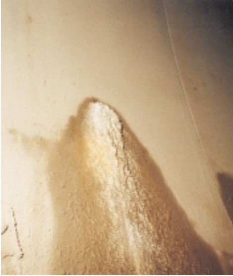
Abb. 2: N3 Bözbergtunnel Weströhre (Aufnahme 29.4.91). Tm 235. Analyse der Ausscheidungen durch das Institut Bachema, Protokoll-Nr. 2684. Resultat: Kalkausscheidungen, keine Spuren von Sulfat oder Chlorid.
