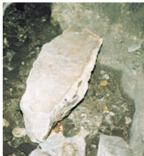
Abb. 8: Bei starker Verdunstung wandert die Kristallisationsfront in das Mauerwerk/Fels zurück, sodass sich der Kristallisationsdruck bereits in den Felsklüften aufbauen kann. Dadurch können grosse Felsbrocken (Bild) mitsamt Gunitschale abgesprengt werden.
