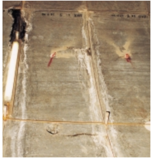
Abb. 5: N3 Bözbergtunnel Tm 1051. Analyse der Ausscheidungen durch das Institut Bachema, Protokoll-Nr. 2693, und Kantonales Laboratorium Aarau, Probe 10. Analyse Bergwasser durch das Institut Bachema, Protokoll-Nr. 2694, und Kantonales Laboratorium Aarau, Proben 09 + 11. Resultat: Natriumausscheidungen mit bis zu 8% Chlorid. Bergwasser mit teilweise extrem hohem Sulfatgehalt. Chloridgehalt immer > 2450 mg/l.
