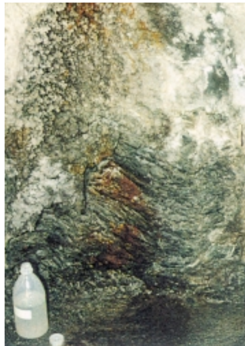
Abb. 9: Entnahmestelle GT 19, 20 m nördlich des Querschlags 26 (Tunnelkilometer 4,830 ab Nordportal).
