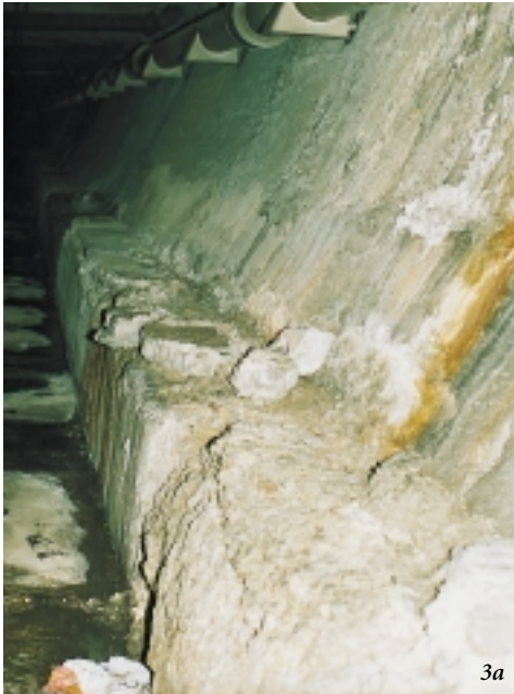
Abb. 3a/b: Zerstörung des Widerlagerbereichs durch Bergwasser, das unter Druck durch die Tunnelschale dringt. Die Zersetzungsprodukte weisen hohe Gehalte an Gips, Ettringit und Thaumazit auf.
