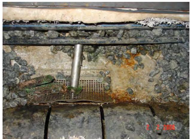
**Bild 6: Detail der Einlauffläche aus Mörtel mit Depotsteinen**
