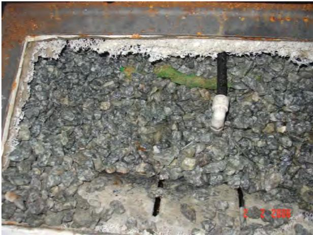
**Bild 3: Detail der Sickerpackung mit Depotsteinen**
