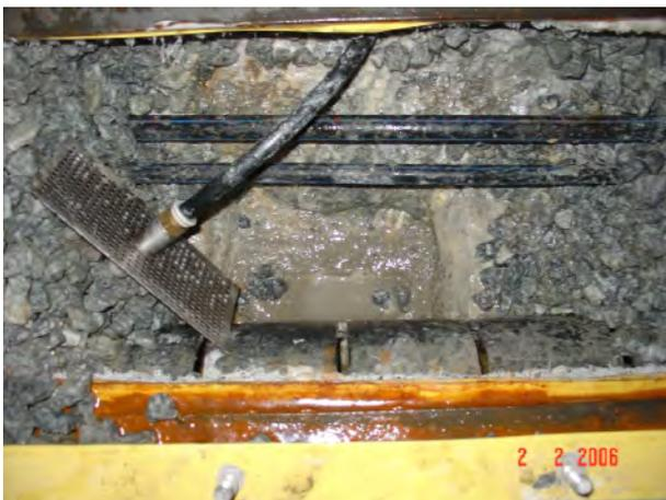
**Bild 5: Detail der Vertiefung für Entnahme der Wasserproben**
