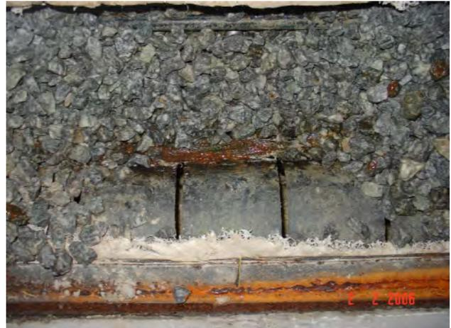
**Bild 2: Sickerpackung mit Depotsteinen**
