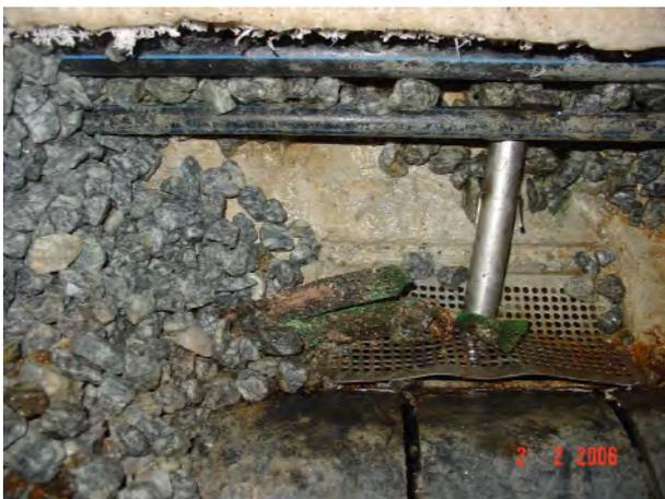
**Bild 5: Detail des Spezialstückes für Entnahme der Wasserproben mit Depotsteinen**
