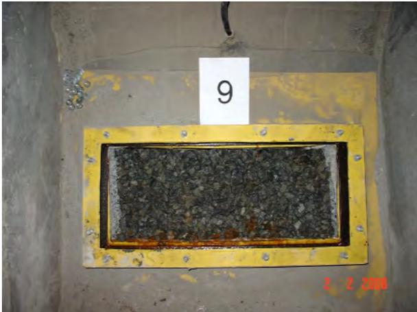
**Bild 1: Oberfläche der Sickerpackung**
