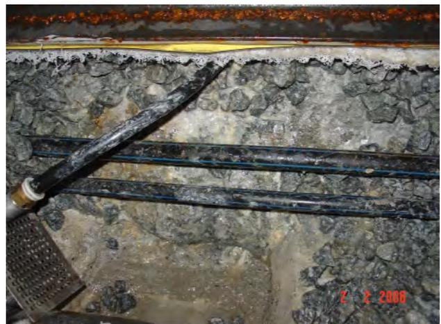
**Bild 6: Detail der Einlauffläche aus Mörtel**
