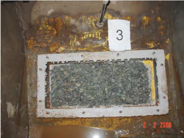
**Bild 1: Oberfläche der Sickerpackung**
