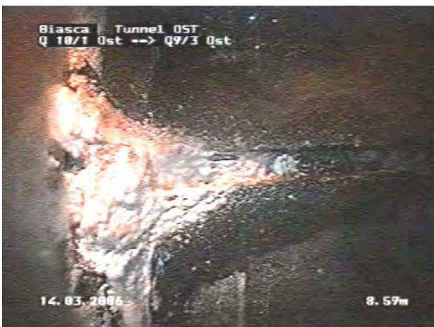
Bild 11: Mit Kalkablagerung abgedeckte Mörtelreste unter einem Schlitz
