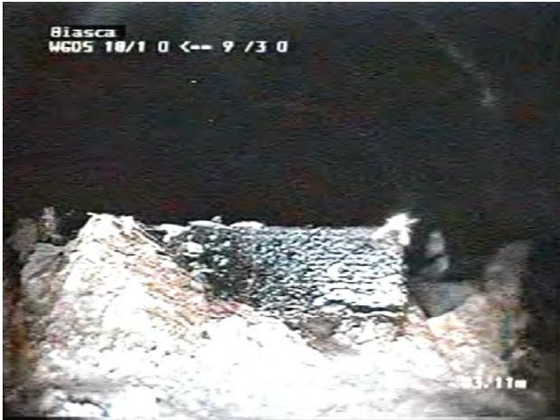
**Bild 13: Abflusshindernis aus harter Ablagerung mit Holzstück**
