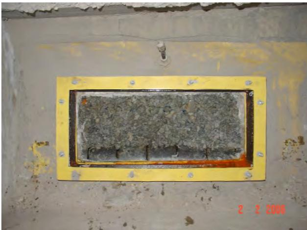
**Bild 3: Oberfläche der Sickerpackung**
