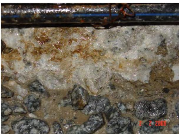
**Bild 5: Detail der Einlauffläche mit leichter Versinterung**
