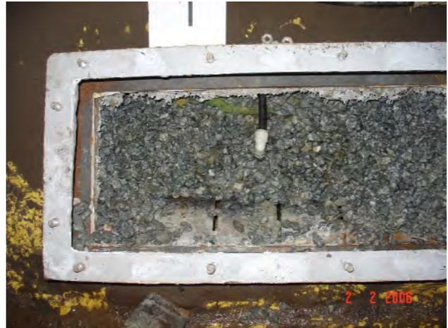
**Bild 2: Sickerpackung mit Depotsteinen**
