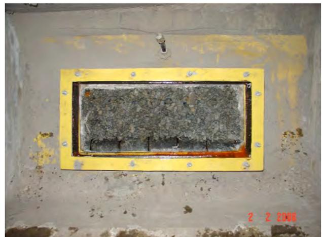
**Bild 2: Oberfläche der Sickerpackung**
