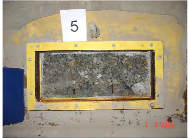
**Bild 2: Oberfläche der Sickerpackung**
