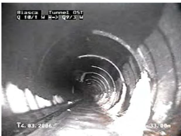
Bild 5: Verkalkung unter den Schlitzen
