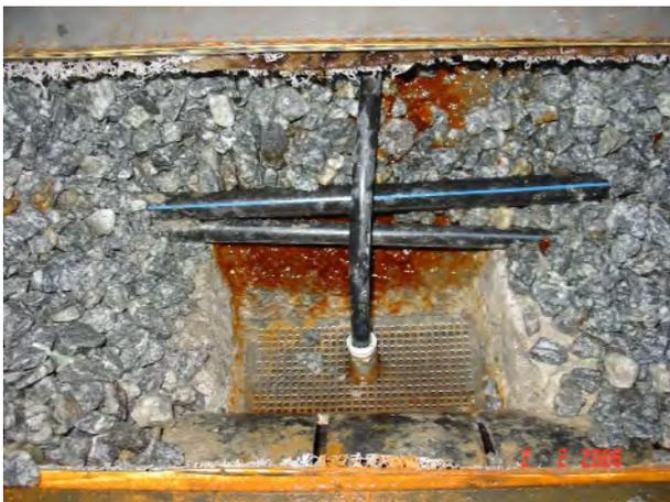
**Bild 3: Detail des Spezialstückes für die Entnahme von Wasserproben**
