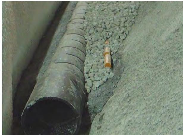
Bild 6: Lage der Depotsteine Typ A in der Sikkerpackung der Gewölbedrainageleitung
