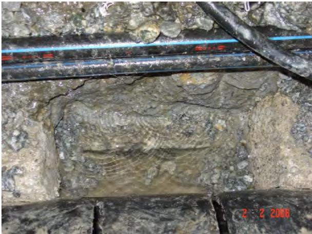
**Bild 3: Detail der Dosierleitungen und der Vertiefung für die Entnahme von Wasserproben.**
