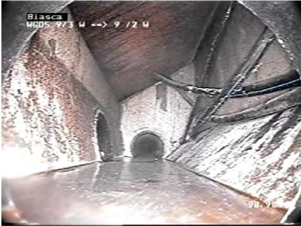
Bild 7: Ende Befahrung, Einmündung in Gewölbedrainageschacht.
