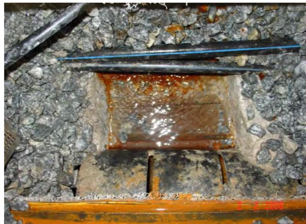
**Bild 4: Detail der Vertiefung für die Entnahme von Wasserproben**
