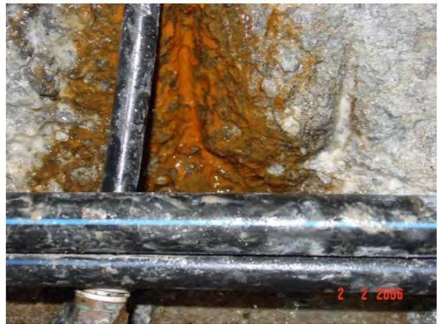
**Bild 4: Detail der Dosierschläuche.**
