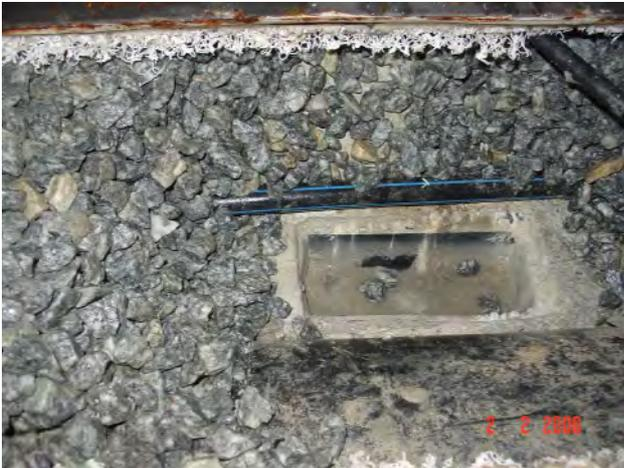
**Bild 3: Detail der Vertiefung für Entnahme von Wasserproben und Dosierleitung.**
