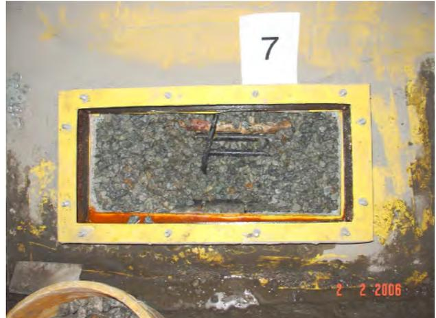
**Bild 2: Sickerpackung mit Depotsteinen**
